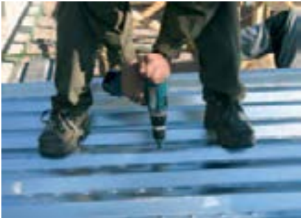
Levyjen kiinnitys porakärkiruuvveilla max. väli 500 mm.
