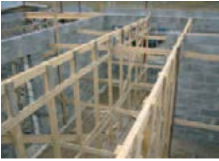
Puusta tehdyt tuet, joiden päälle liittolevyt asetetaan.
