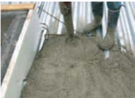
Betoni lasketaan ensin päätyjen ja välitukien kohdalle.
